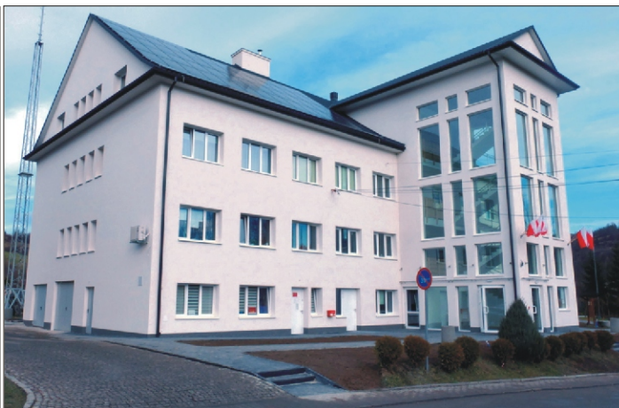
Modernizacja budynku Urzędu Gminy aktualny stan zewnętrzny
