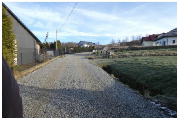
Modernizacja części drogi gminnej Trojaki w Koninie
