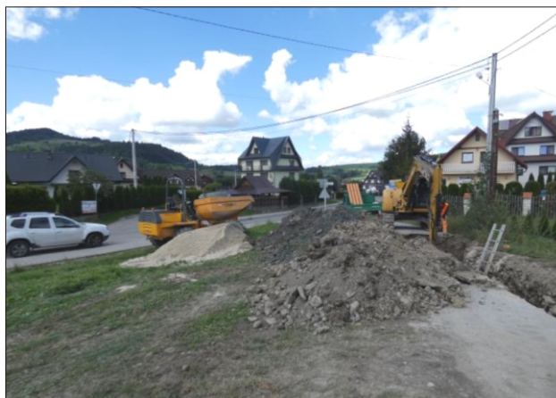
Budowa kanalizacji sanitarnej w Porębie Wlk. Koninki
