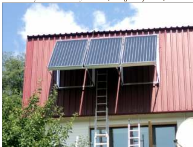
Instalacja solarów. Tu na zdjęciu - w Porębie Wielkiej
